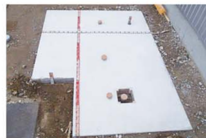
コンクリート工事
