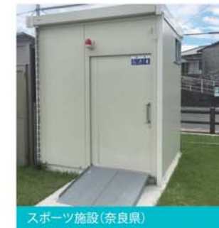
スポーツ施設(奈良県)
